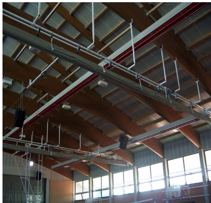
Fig.2 – Conducto radiante GIRAD sobre pista polideportivo
