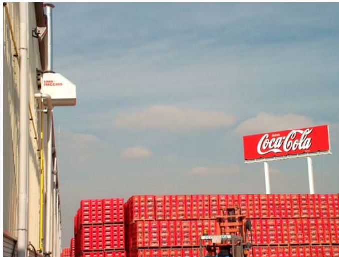
Instalación de Generador de calor GIRAD GSR300 en exterior NAVE VIDRIO
