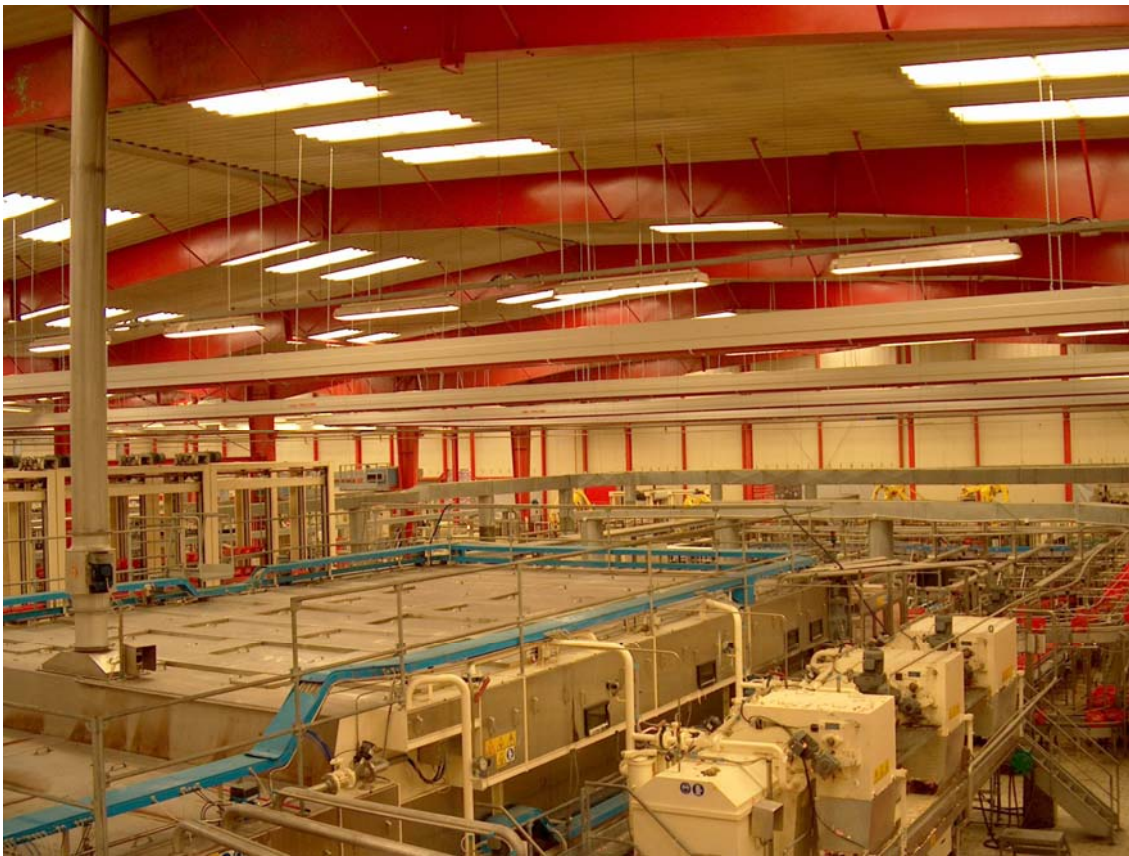
Instalación de Conductos Radiantes GIRAD en NAVE VIDRIO
