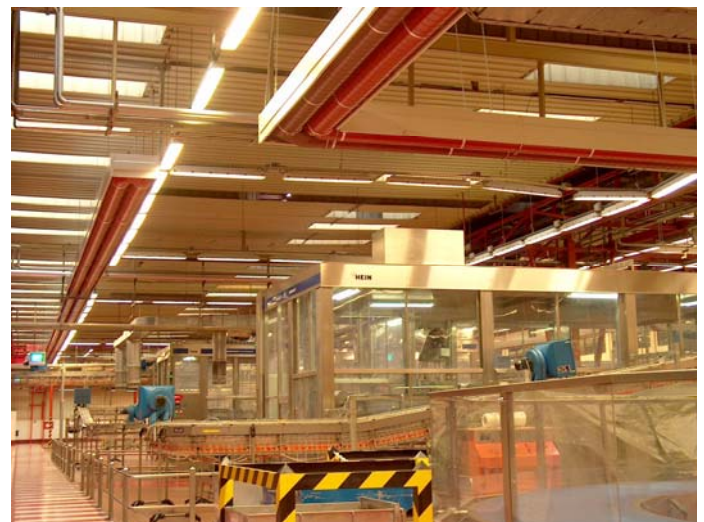
Instalación de Conductos Radiantes GIRAD en NAVE LATAS+PET
